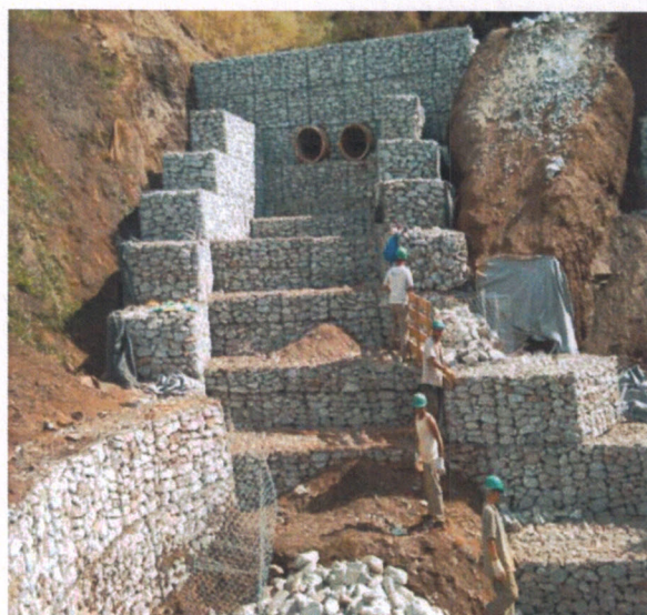
Figura 20 – Obra Escada Dissipadora – Canopus
