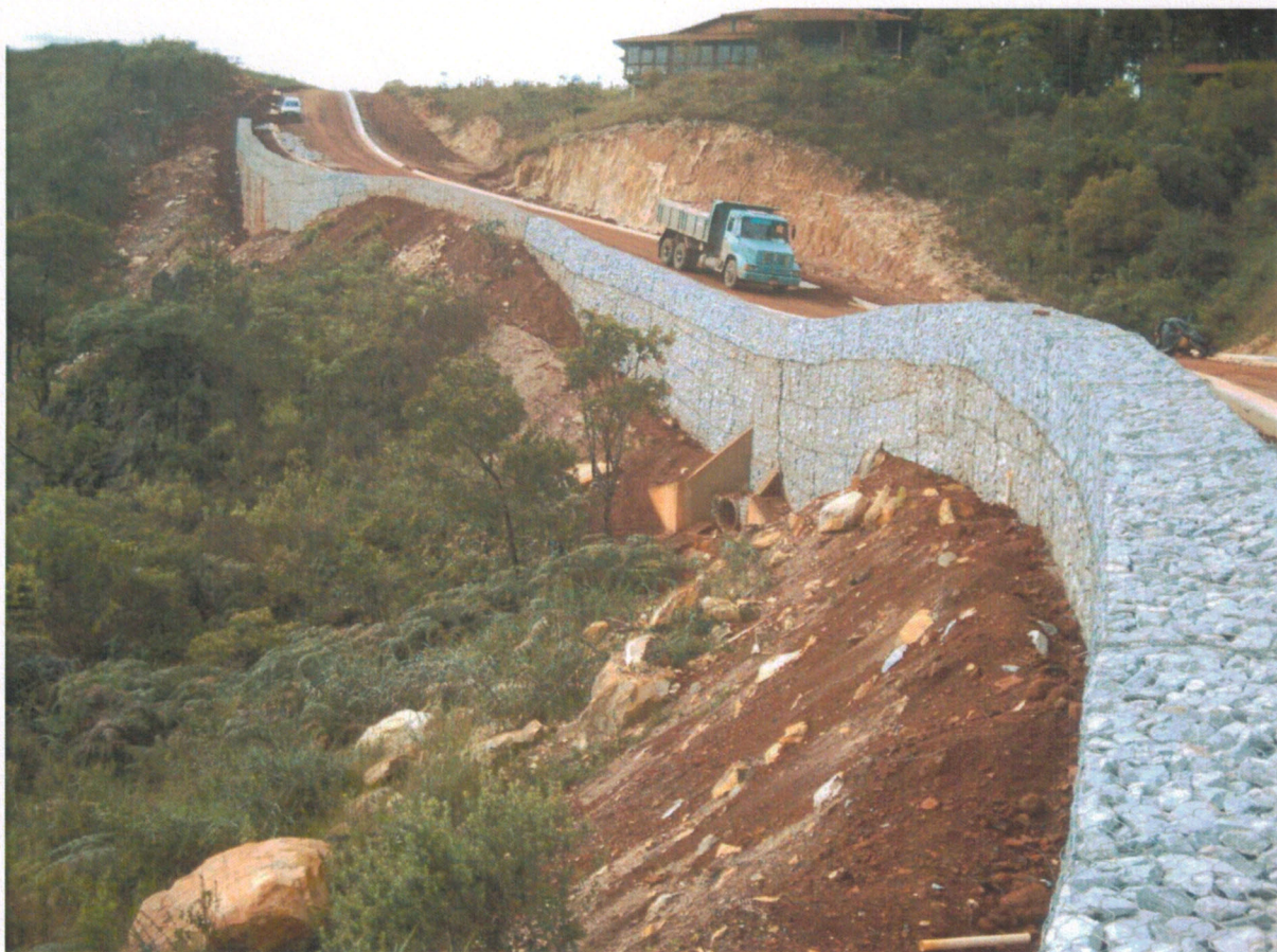
Figura 31 – Obra de Contenção em Nova Lima – MG
