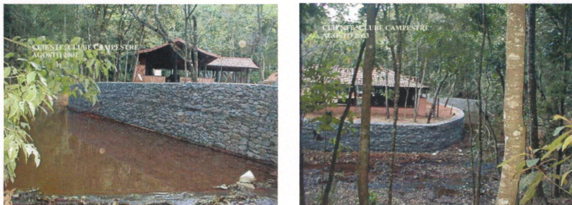
Figura 23 – Obra de Arrimo – Gabião tipo caixa
