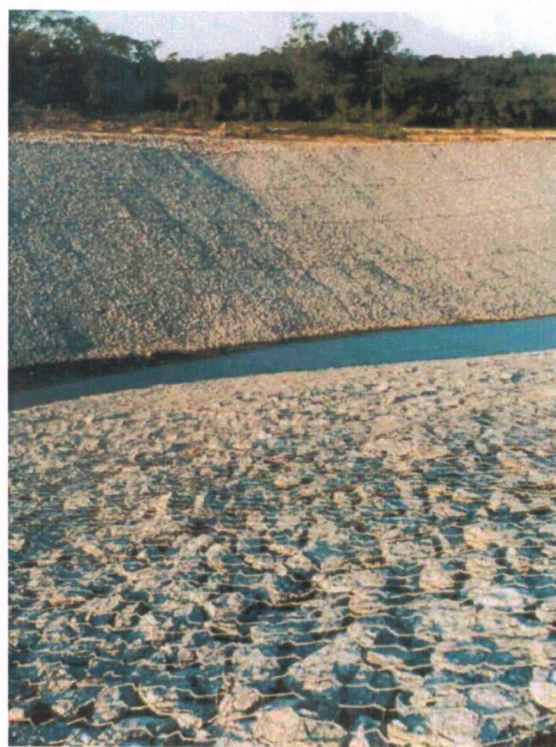
Figura 10 – Obra de Revestimento – Gabião tipo colchão
