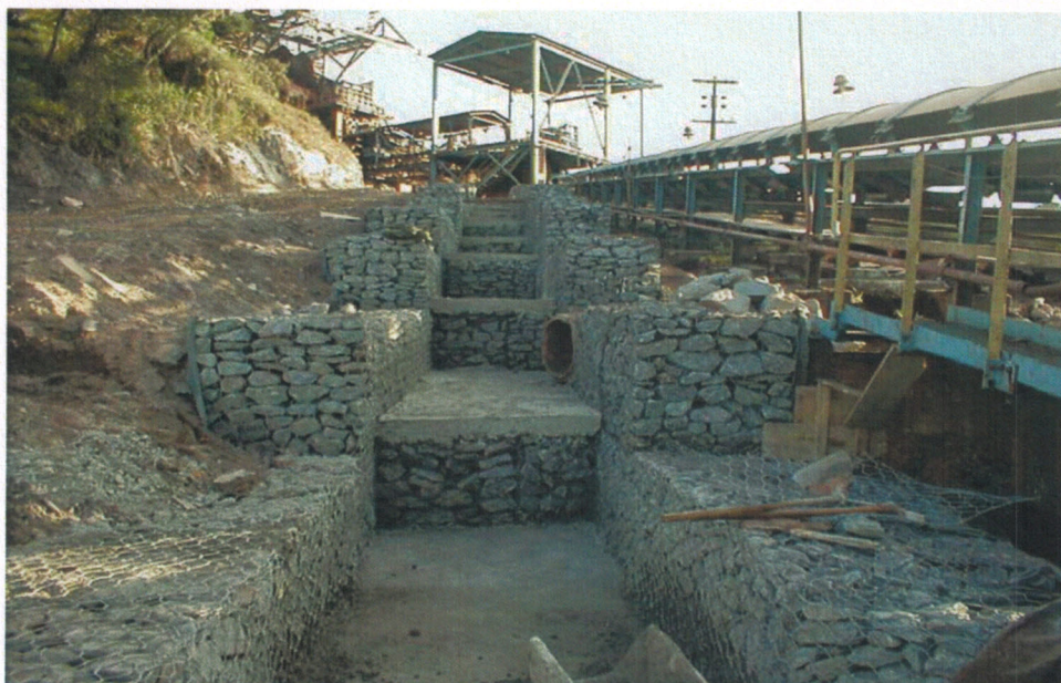
Figura 19 – Obra Escada Dissipadora – CVRD – Itabira MG
