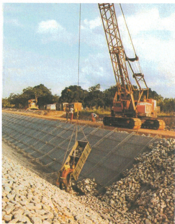
Figura 10 – Obra de Revestimento – Gabião tipo colchão
