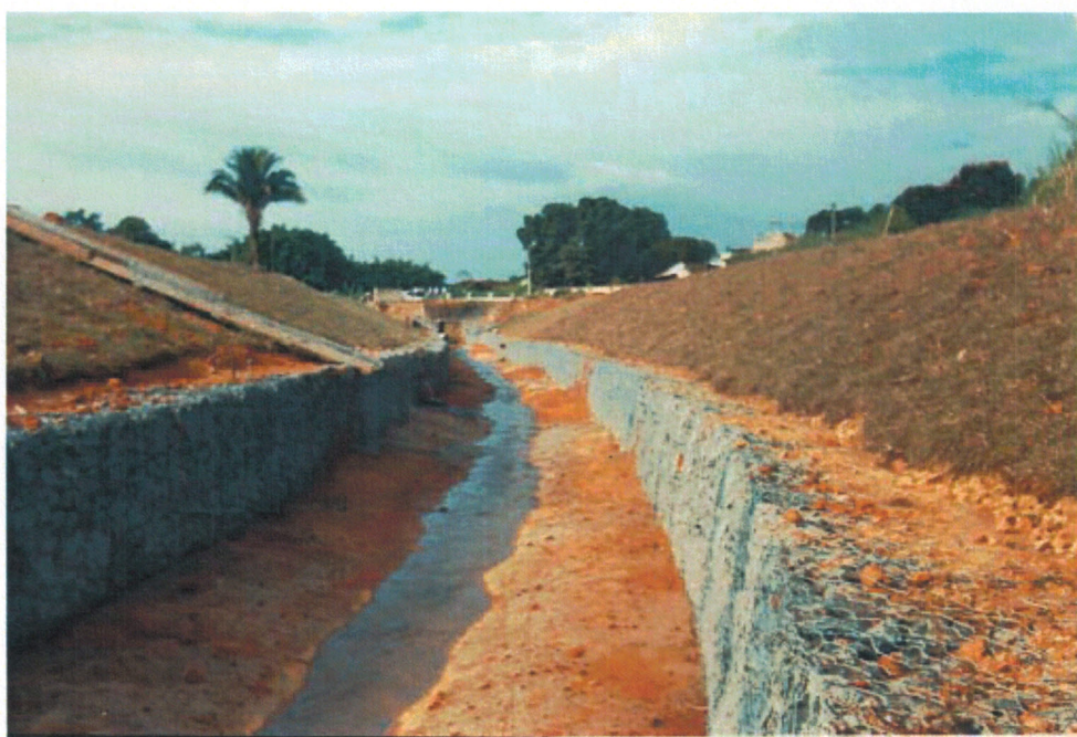
Figura 26 – Obra de Canalização – Gabião tipo caixa / colchão
