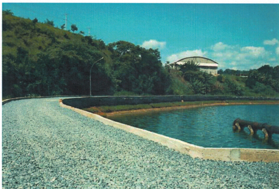
Figura 28 – Obra de Dique – Gabião tipo caixa
