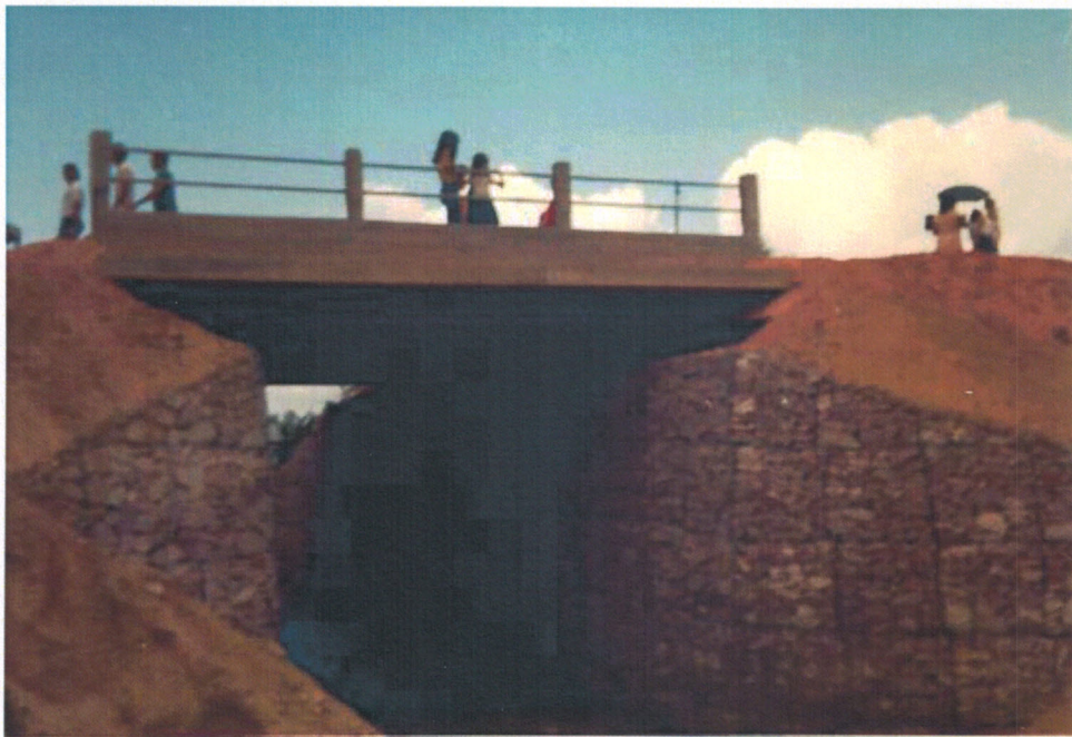
Figura 27 – Obra de Apoio para Ponte – Gabião tipo caixa
