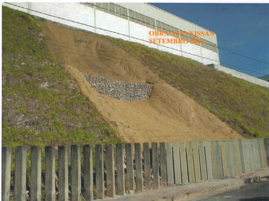
Figura 21 – Obra de Controle de Erosão – Gabião tipo caixa
