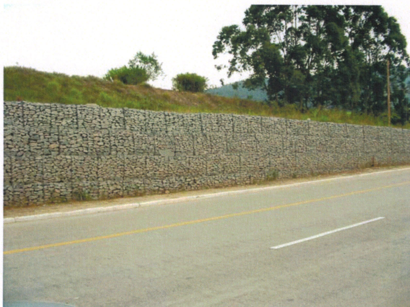
Figura 9 – Obra de Arrimo – Gabião tipo caixa
