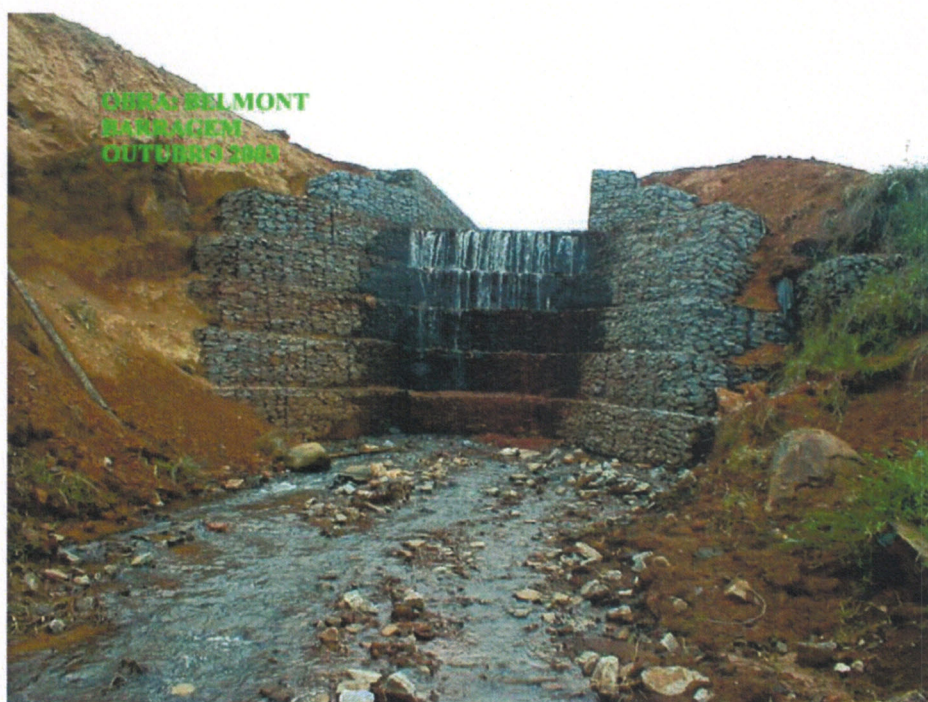
Figura 22 – Obra de Barragem – Gabião tipo caixa
