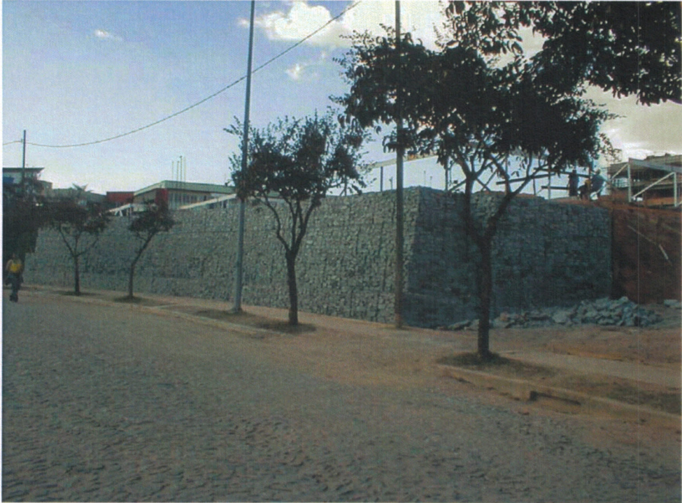
Figura 29 – Muro de Arrimo – Escola de Engenharia UFMG
