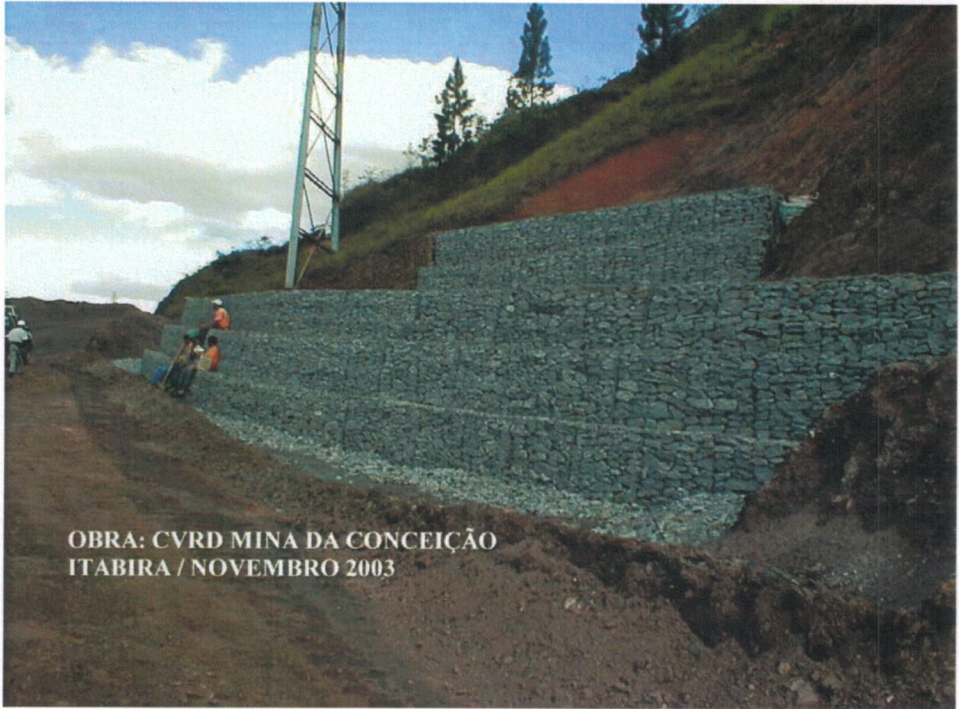
Figura 15 – Obra de Arrimo – Gabião tipo caixa
