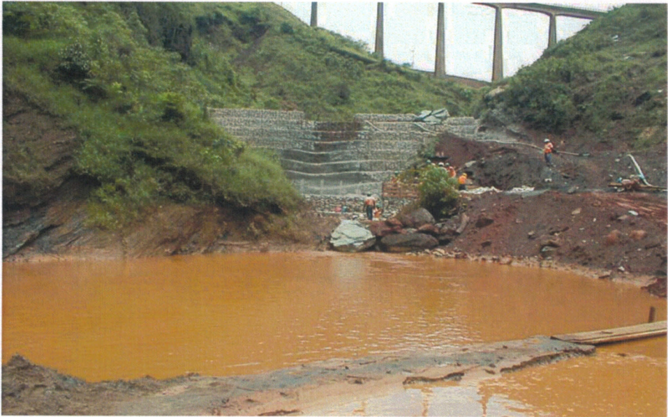
Figura 17 – Obra de Barragem – Gabião tipo caixa
