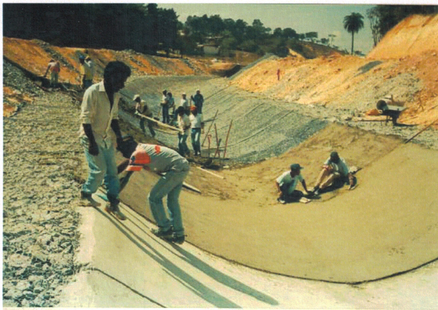
Figura 25 – Obra de Revestimento – Gabião tipo colchão
