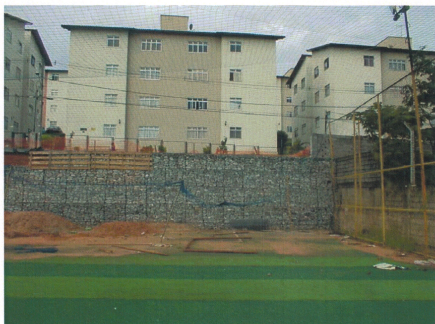
Figura 24 – Obra de Arrimo – Gabião tipo caixa
