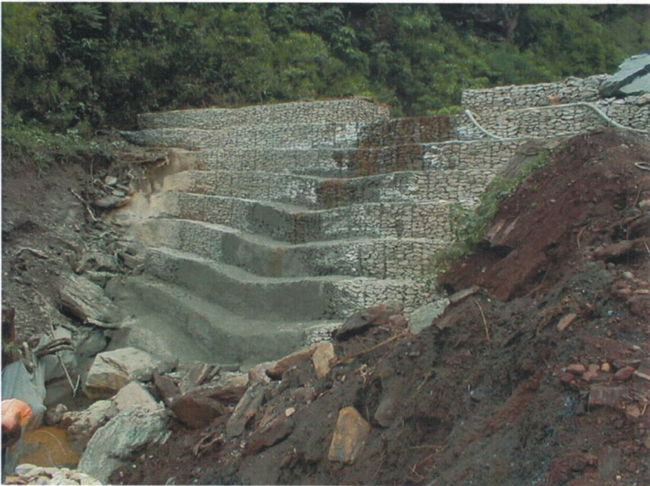
Figura 16 – Obra de Barragem – Gabião tipo caixa
