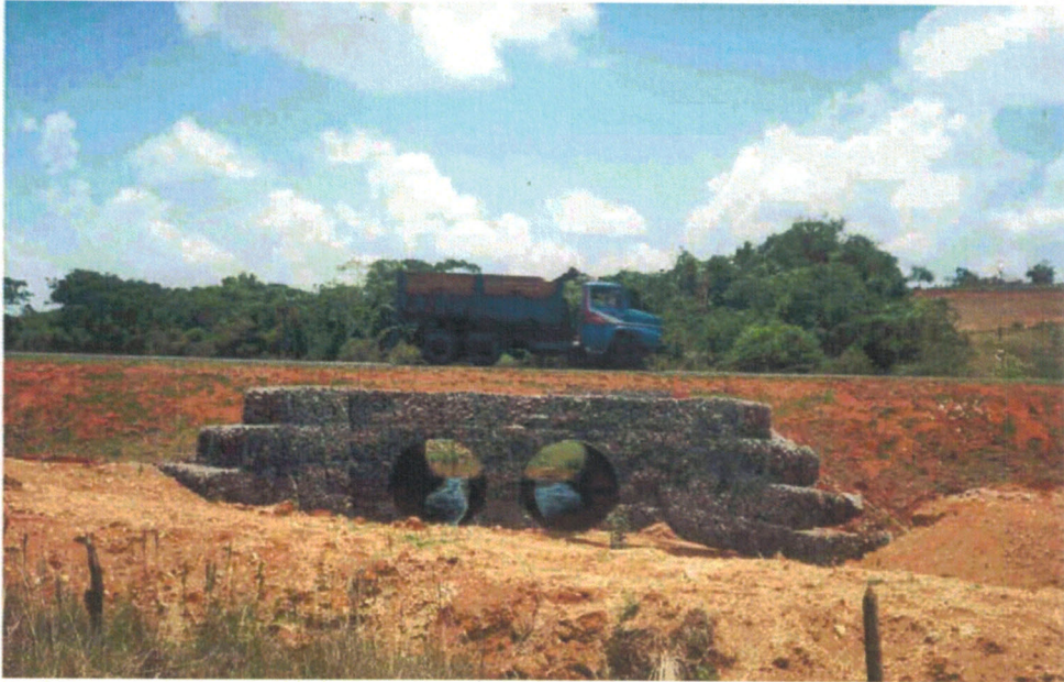
Figura 12 – Obra de Arrimo e Proteção de Canalização – Gabião tipo caixa
