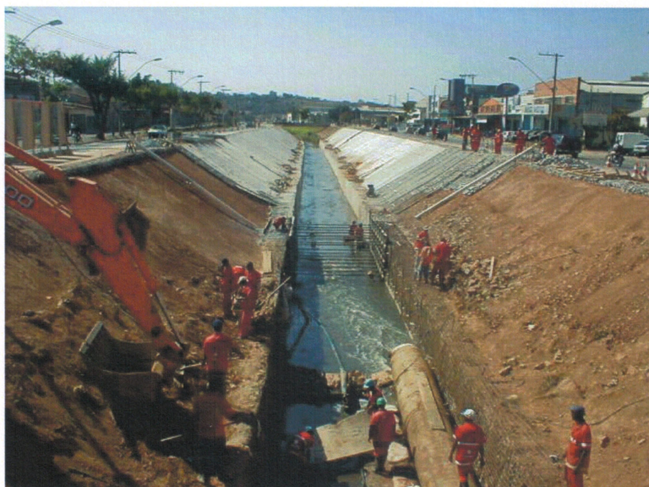
Figura 14 – Obra de Revestimento de Canal – Gabião tipo colchão
