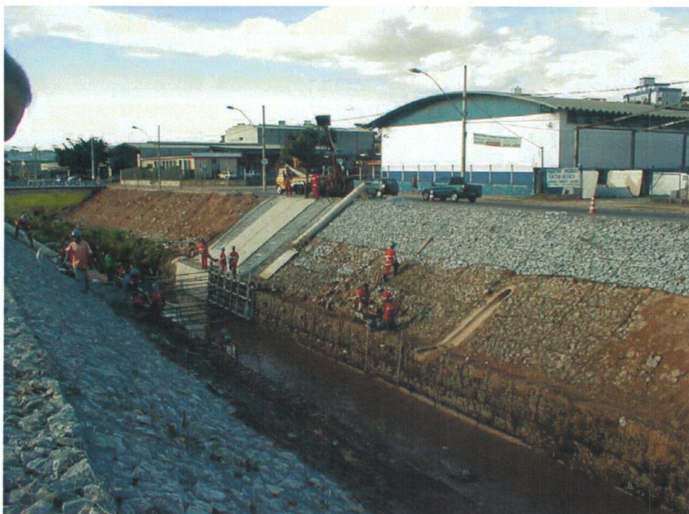
Figura 13 – Obra de Arrimo – Gabião tipo caixa
