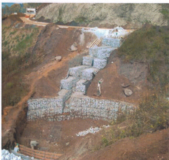
Figura 20 – Obra Escada Dissipadora – Canopus
